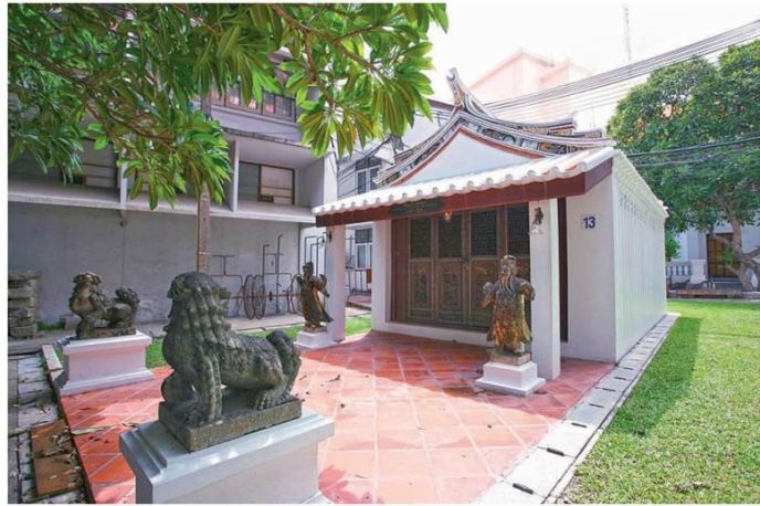
'เก่งนุกิจราชบริพาร' หลังคามุงกระเบื้องจีน บริเวณจั่ว หนานัน และลั่นหลังคาเขียนสีลายกระบวนจีน
