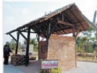
(บน) วิธีคลุกเคล้าส่วนผสม (ล่าง) บ้านดินที่อยู่ระหว่างการก่อสร้าง
